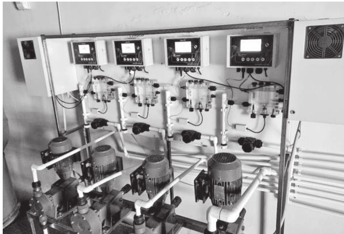
Очистные сооружения в Хушете
