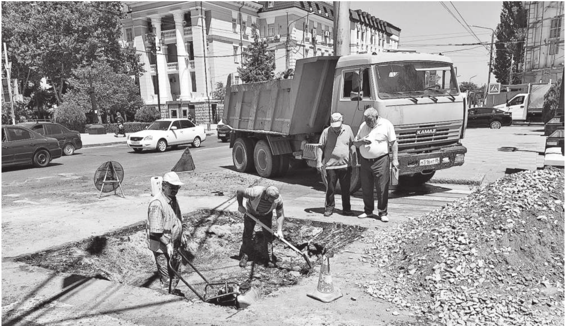
Обвал на дороге на углу улицы Дахадаева и проспекта Гамзатова
