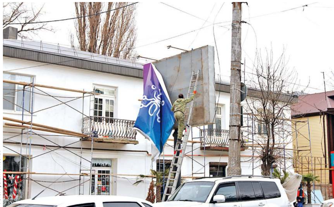
Демонтаж рекламного щита
