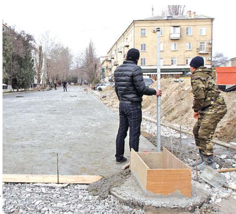
Бетонное основание под асфальт
