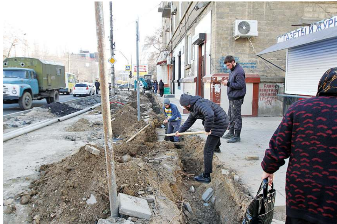
Мастера интернет-провайдеров протягивают провода в кабель каналы
