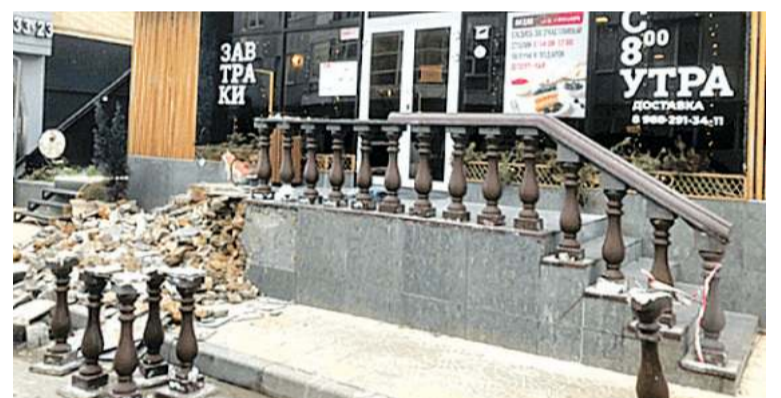
Снос входной группы на ул. Ярагского
