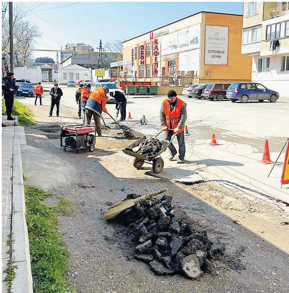
Ремонт на всех дорогах планируют завершить в течение апреля
