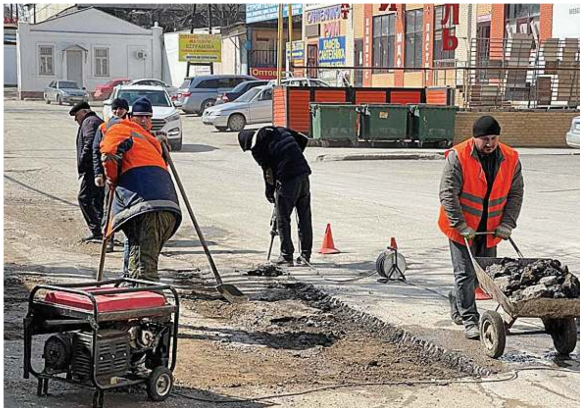
Ямочный ремонт на Бейбулатова
