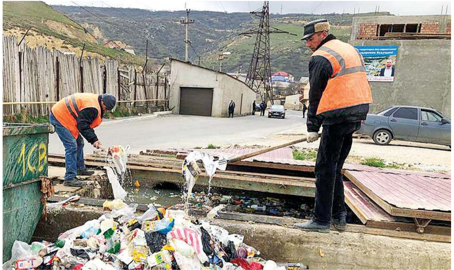
Чтобы не допустить затопления улиц, отстойники приходится очищать вручную
