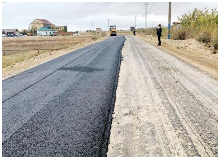
Ремонт дороги, ведущей к целебному источнику в Избербаше
