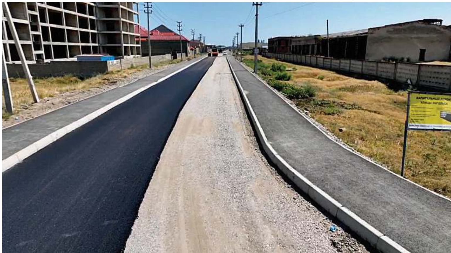
Ремонт дороги в микрорайоне «Энергетик»
