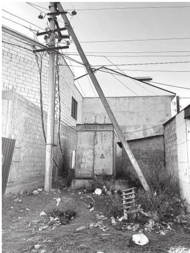
По причине ветхости линий электропередачи происходят частые отключения электроэнергии
