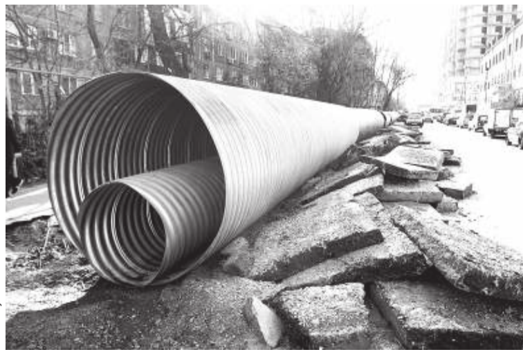
Трубы для капремонта ливневых сетей
