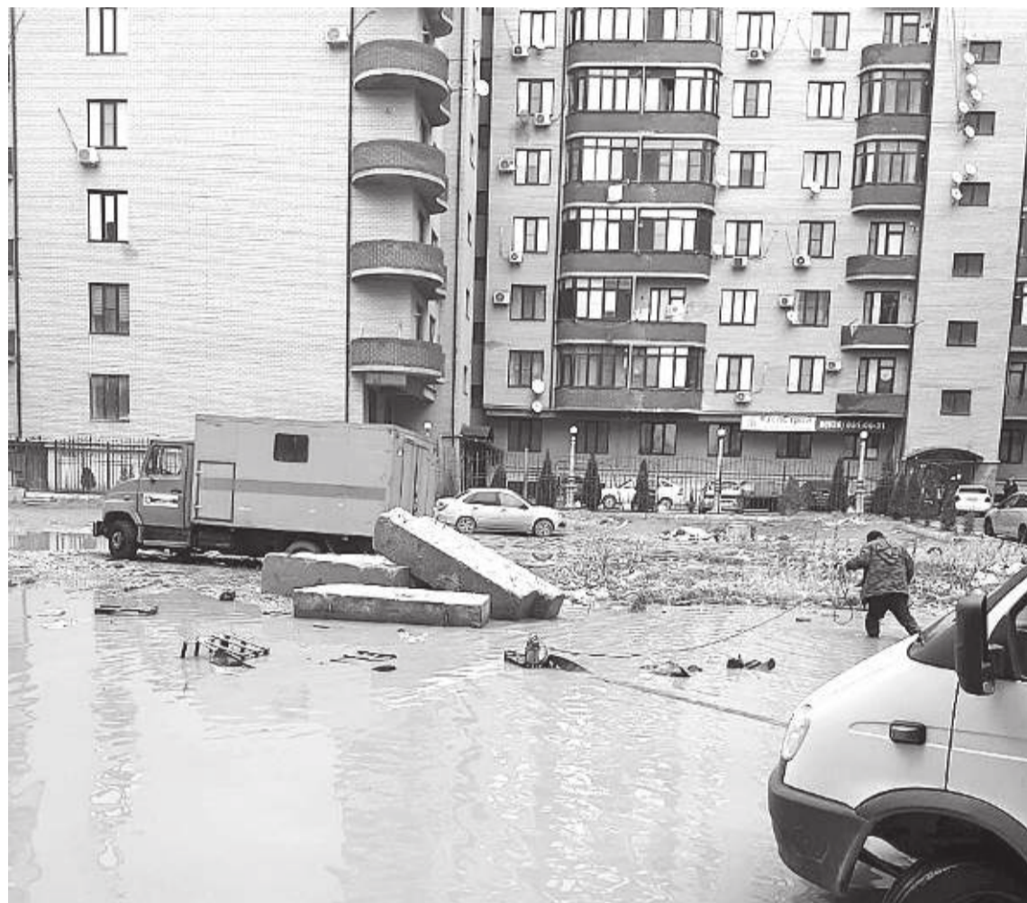
Подтопление на ул. Кадарской
