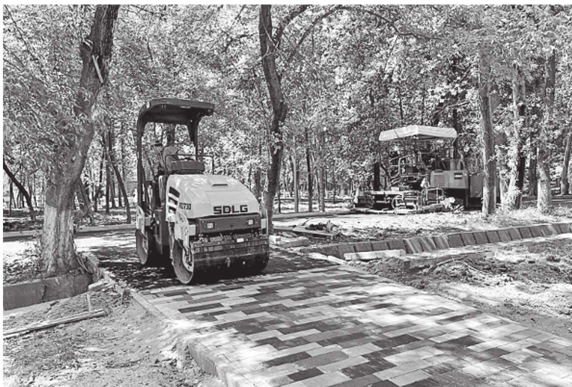
Практически завершены работы по укладке тротуарной плитки
