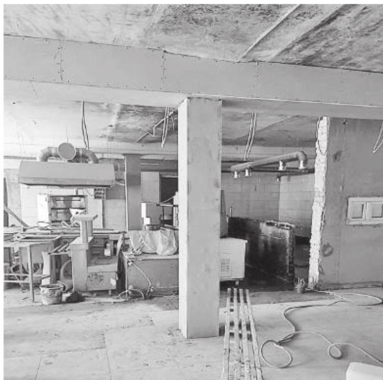
Ремонт в столовой
